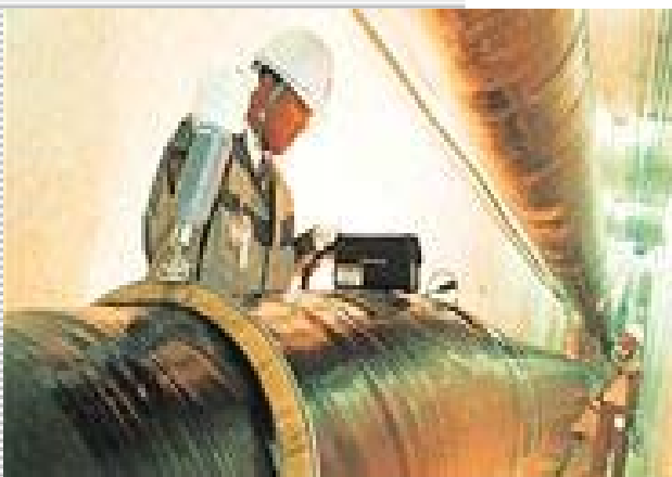
共同溝でのガス管の点検
