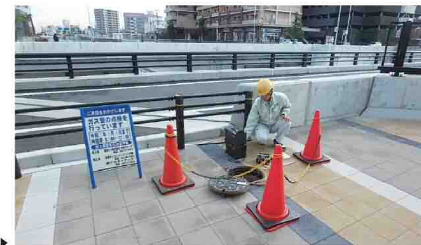
防食電位測定の作業風景▶
