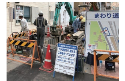
▲土木工事への立会い
