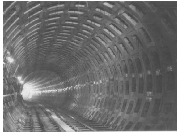
地下鉄 池下～覚王山のトンネル
