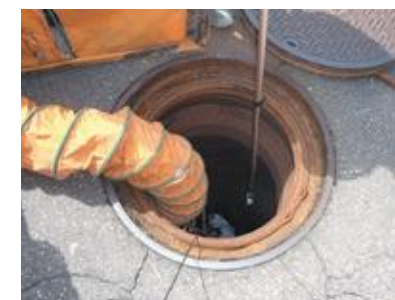
▲マンホール内点検(カメラ挿入)
