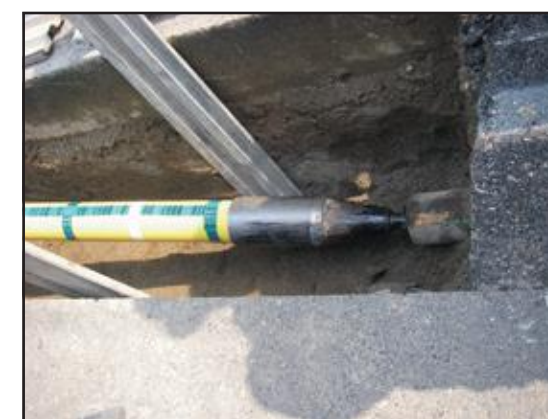
▲ガス管の挿入側
