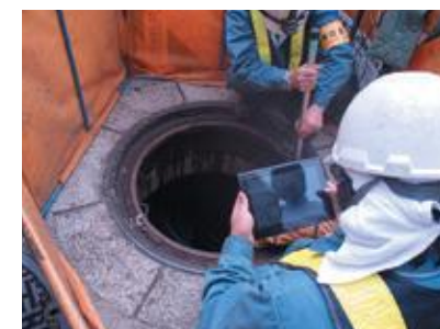
▲マンホール内点検(タブレット操作)
