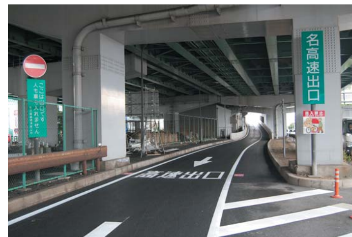
▲高速出口における誤進入対策
