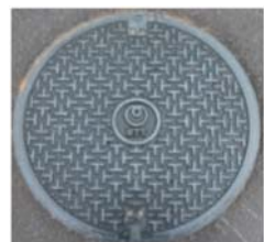
▼旧型マンホール鉄蓋
