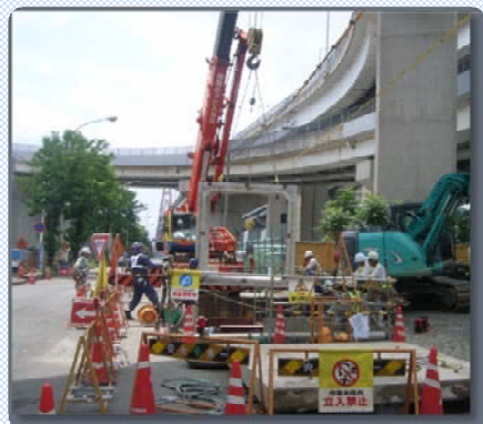
▲プレハブ式マンホールの設置
