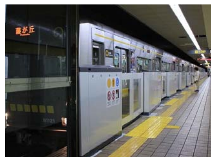
▲供用開始後(ホーム側)
