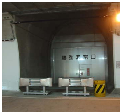
非常口（トンネル）
