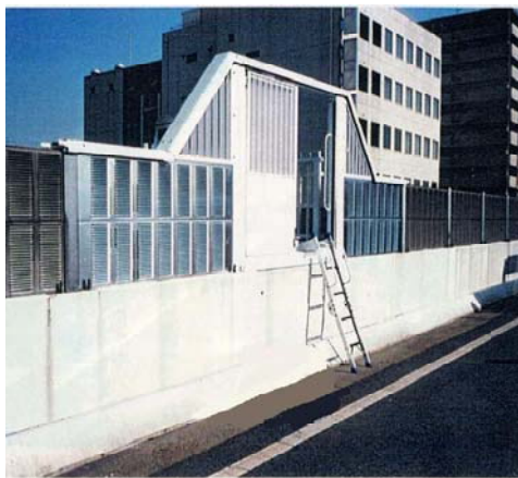
非常口（高架橋）
