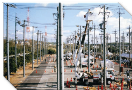
▲配電設備復旧訓練
