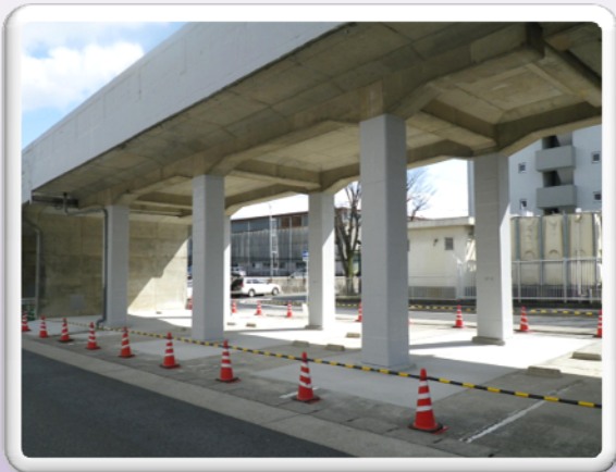
▲繊維シート巻き工法
