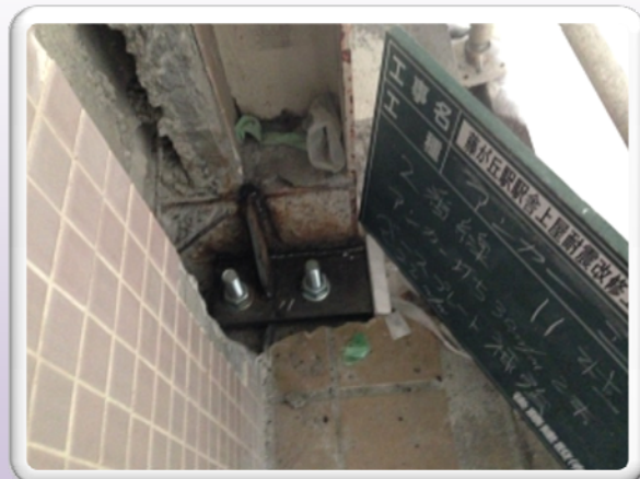
▲柱脚部アンカーボルトの増設
