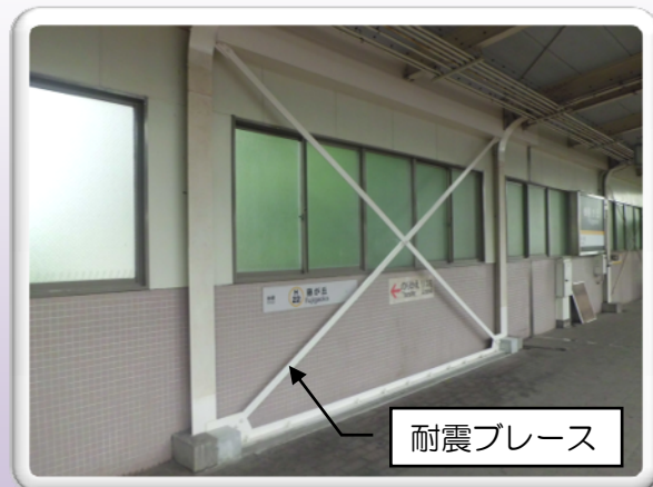
▲耐震ブレースの新設
