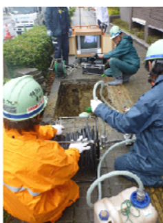
復旧作業の様子
