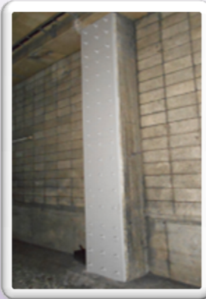
▲一面補強工法
