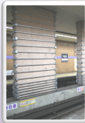
▲リブバー工法
