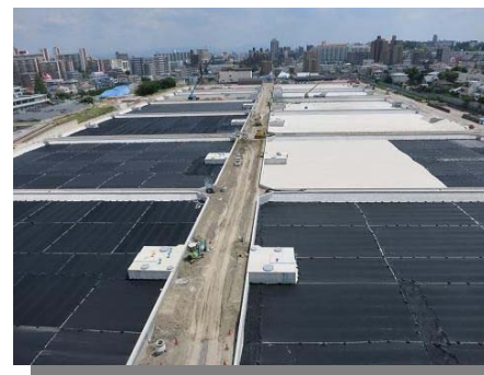
▲緩速ろ過池工事状況
