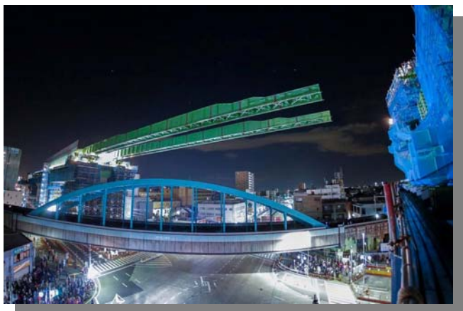
▲新幹線・国道1号上での送り出し架設状況
