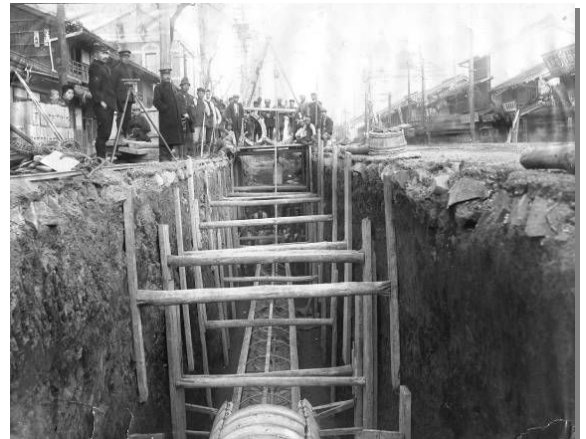
▲銘板の工事写真
