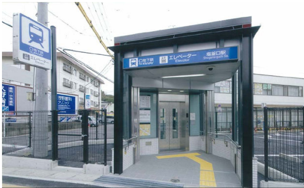
エレベーター(塩釜口駅)
