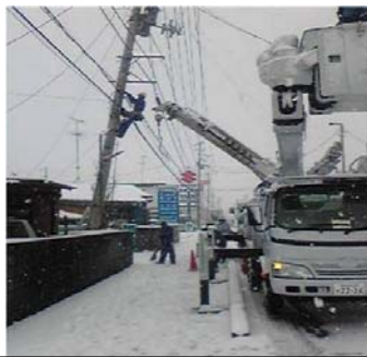
電柱傾斜手直し
