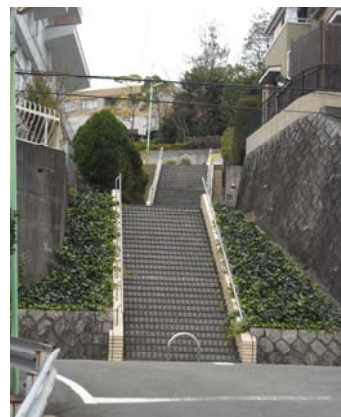
▲写真①階段道路(千種区)
