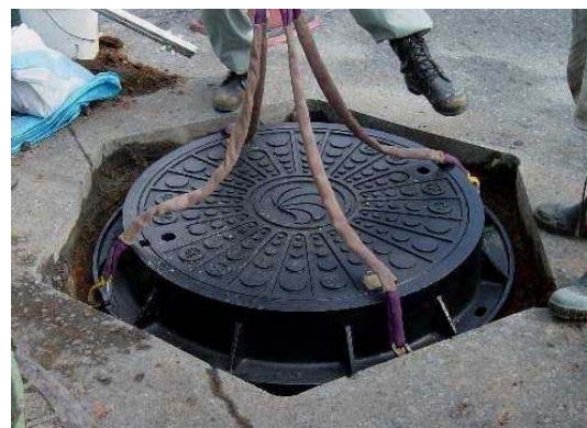
▲新工法【六角工法】
