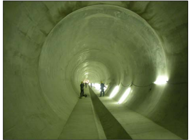
堀川右岸に建設中の貯留管
