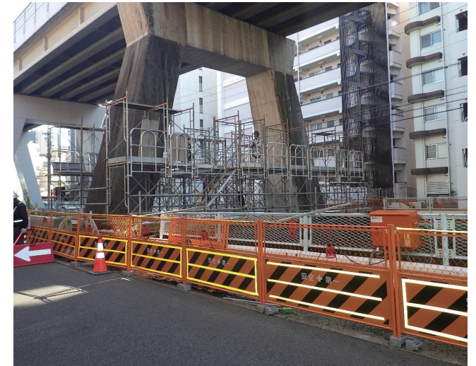
東山線上社駅～本郷駅間の耐震補強工事(昨年11月撮影)
