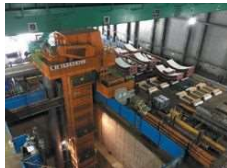
工事現場内の様子
