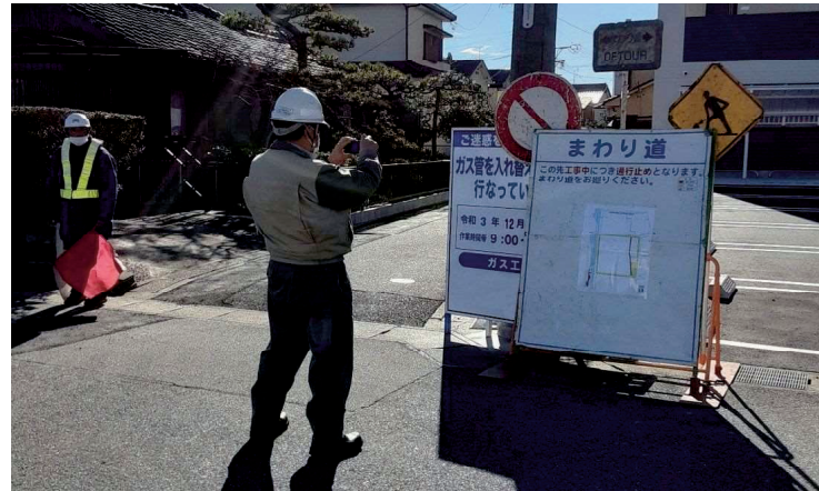
現場パトロール実施状況▶
